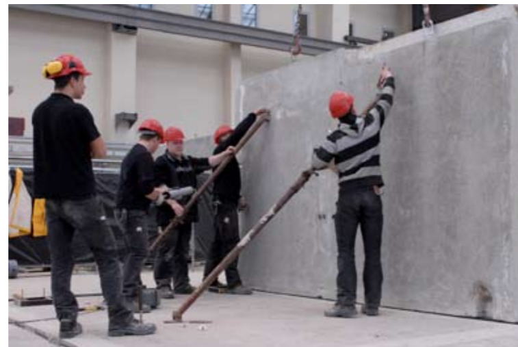
Auszubildende der ersten Lehrbaustelle beim Montieren der Rückwand.
