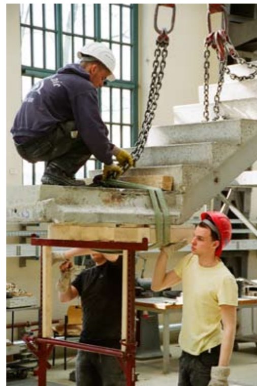
Montage der Treppenelemente
