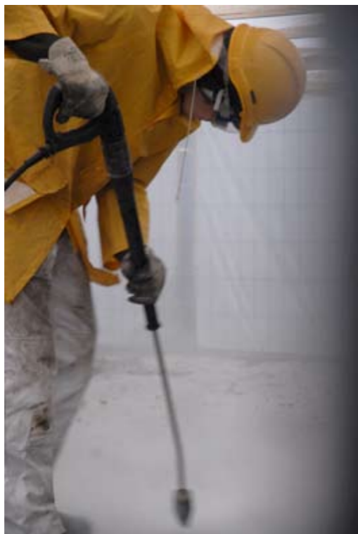
Grobreinigung der Platten mit Hochdruckreiniger
