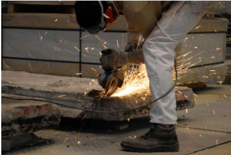
Überarbeiten der Bauteile
