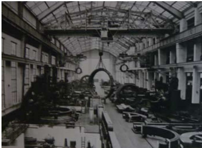
Historische Ansicht der AEG-Halle
