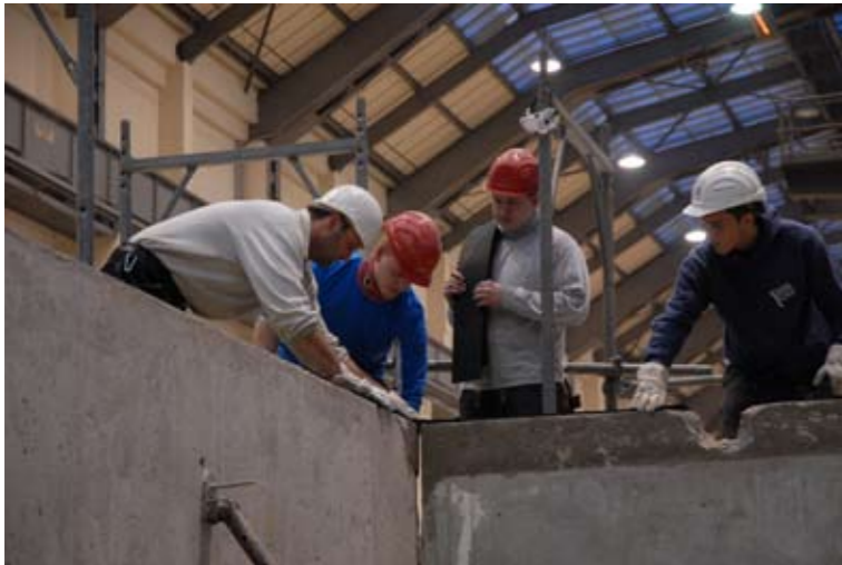
Vorbereitungen für die Auflagerung der Zwischendecke
