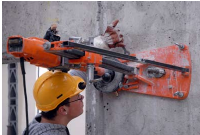
Setzen von Kernbohrungen
