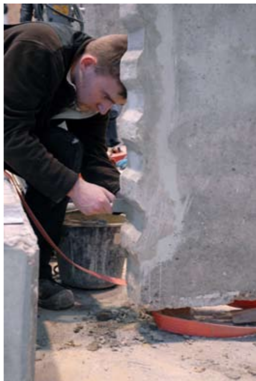
Betonkosmetische Ausbesserung der Platten
