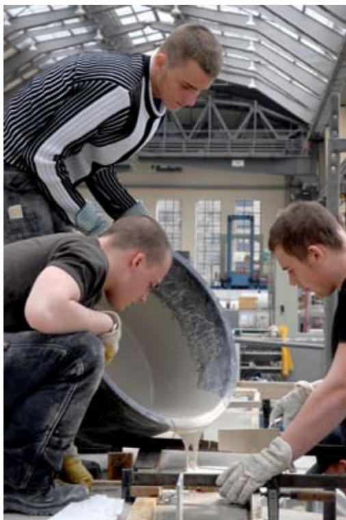
Betonarbeiten an den Bauteilen
