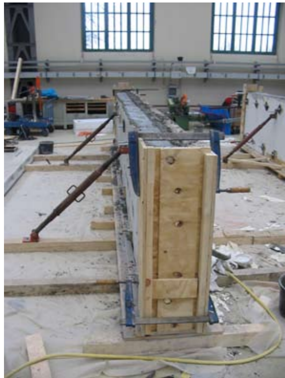
Herstellung der Sandwich-Decken
