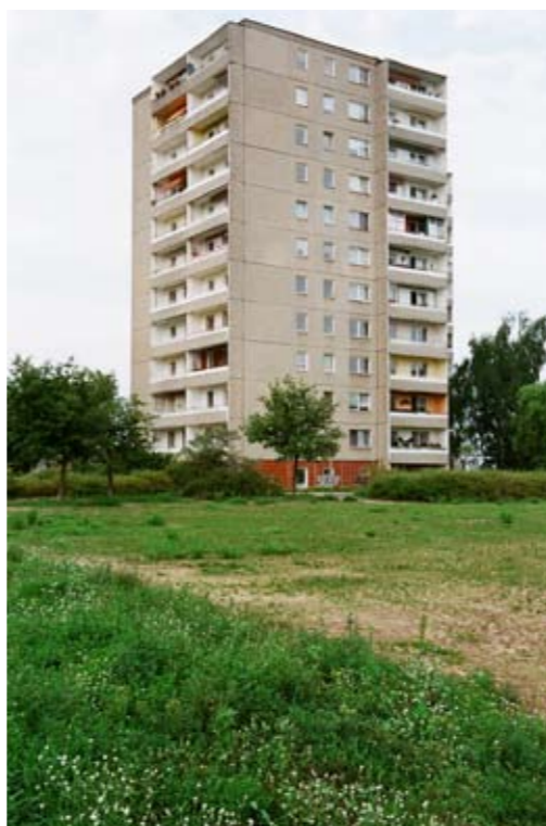
Punkthochhaus in Neuberesinchen (Frankfurt/Oder)
