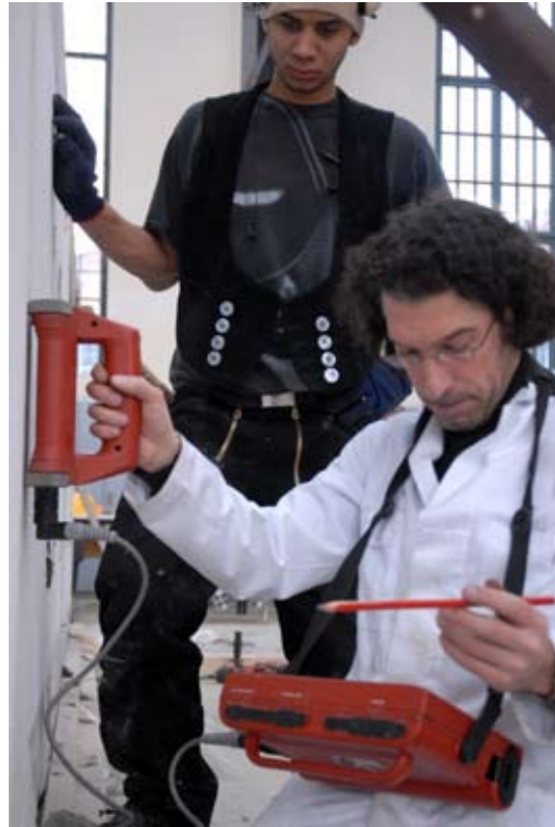
Bewehrungssuche mit dem FerroScan
