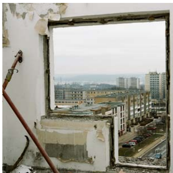
Blick aus dem Abrissgebäude in Frankfurt/Oder
