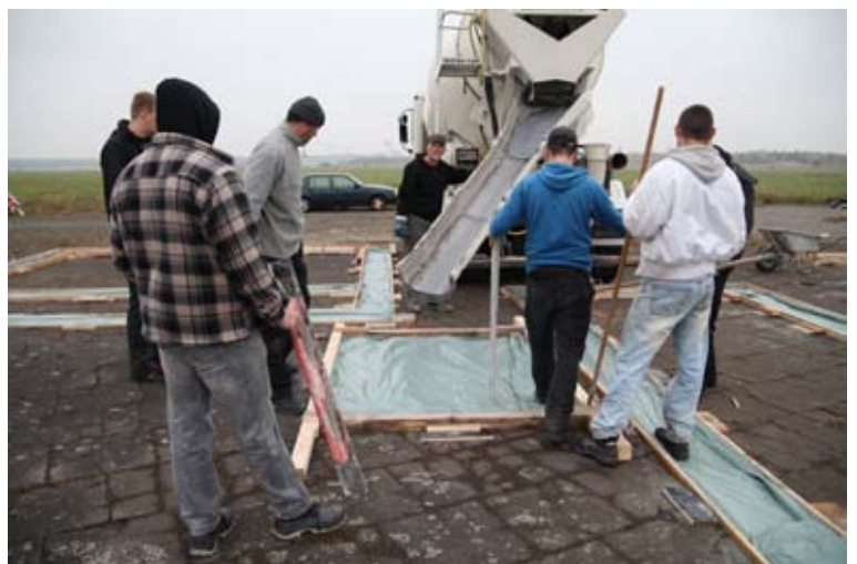
Lehrbaustelle: Umzug des Gebäudes zum zweiten Standort auf der Tempelhofer Freiheit
