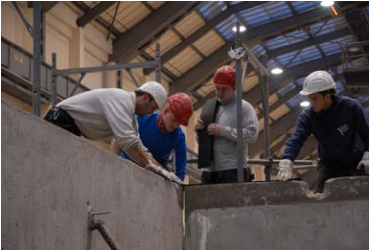
Vorbereitungen für die Auflagerung der Zwischendecke
