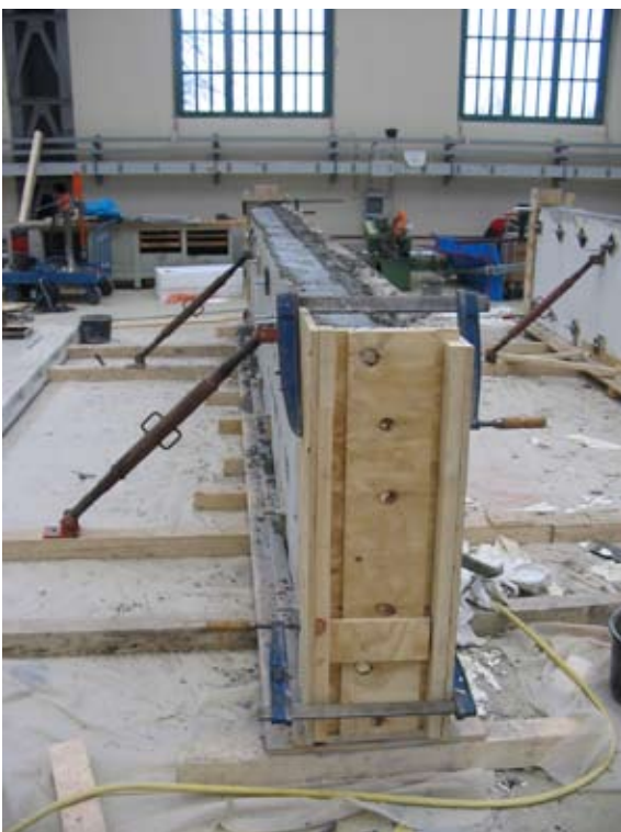
Herstellung der Sandwich-Decken
