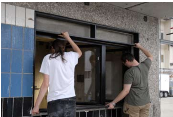
Präsentation der Fenster und Besprechung in der Lehrwerkstatt Brandenburg-Friesack, Fenstereinbau in der Peter-Behrens-Halle
