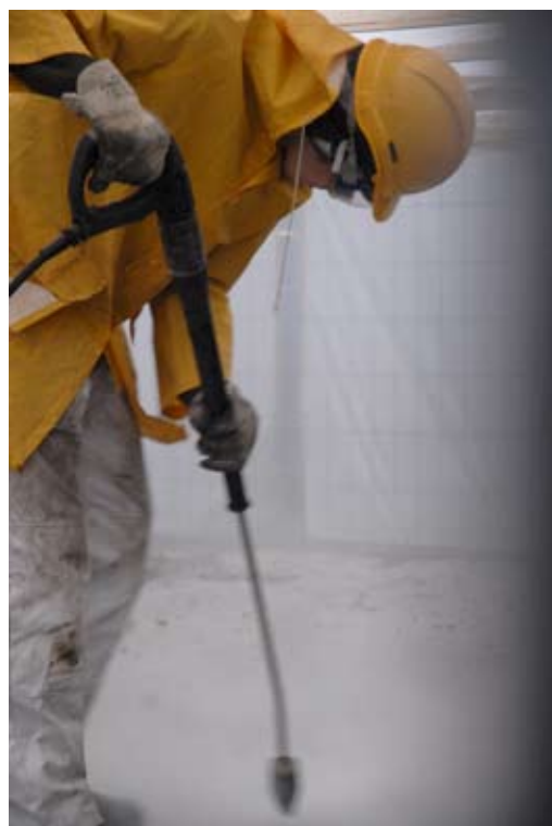
Grobreinigung der Platten mit Hochdruckreiniger
