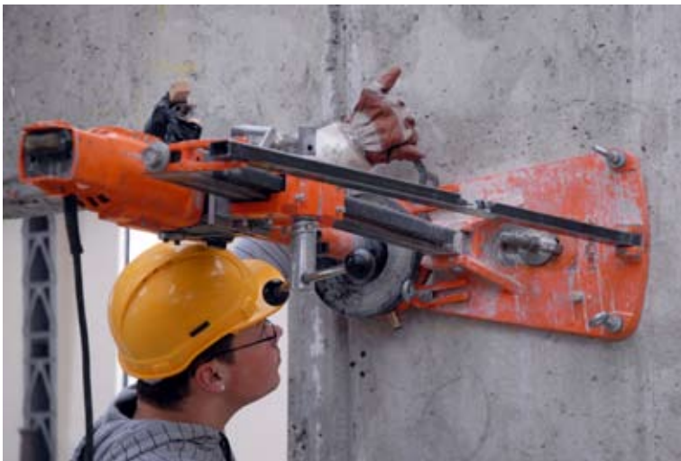
Setzen von Kernbohrungen
