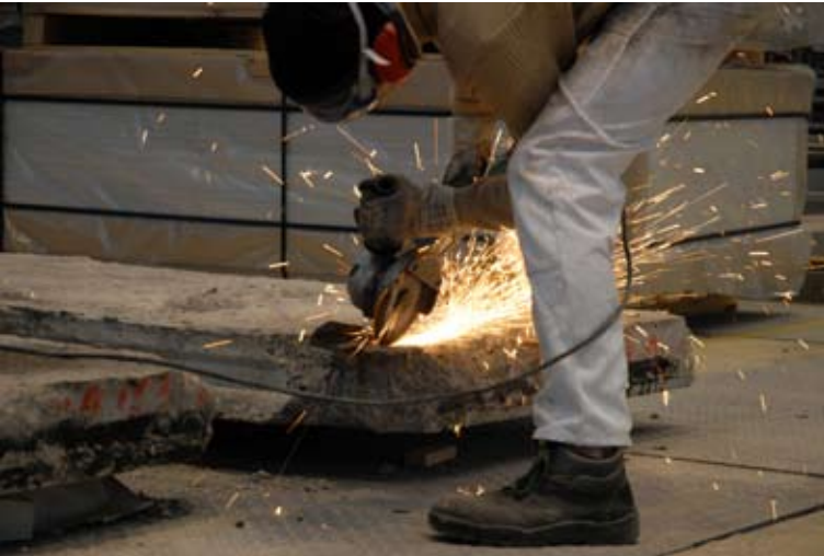
Überarbeiten der Bauteile
