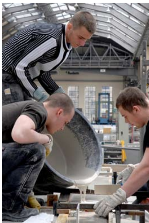
Betonarbeiten an den Bauteilen
