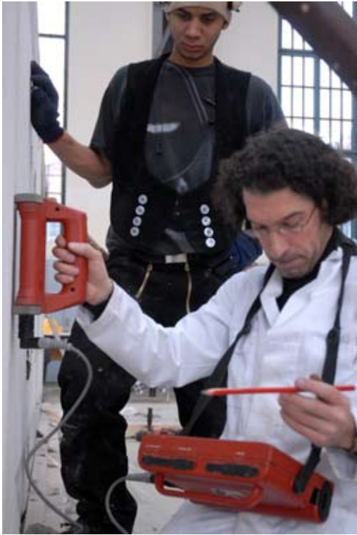
Bewehrungssuche mit dem FerroScan
