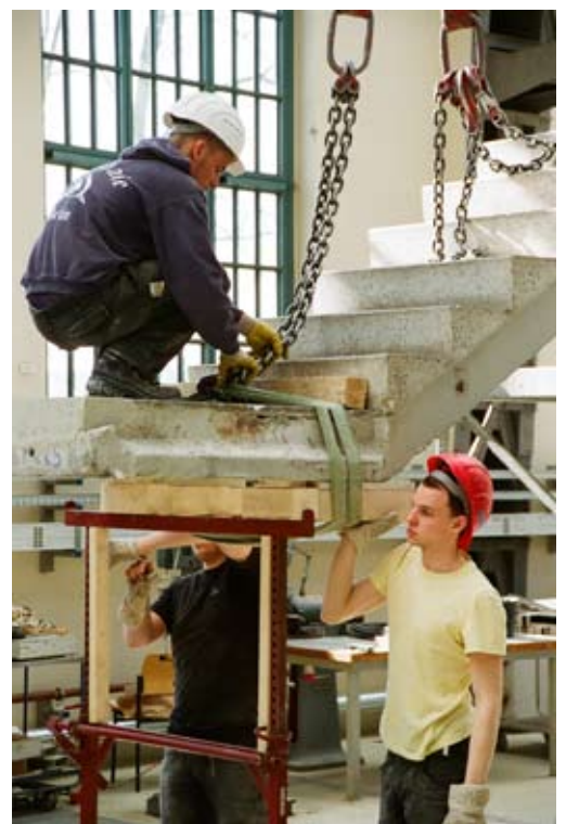
Montage der Treppenelemente
