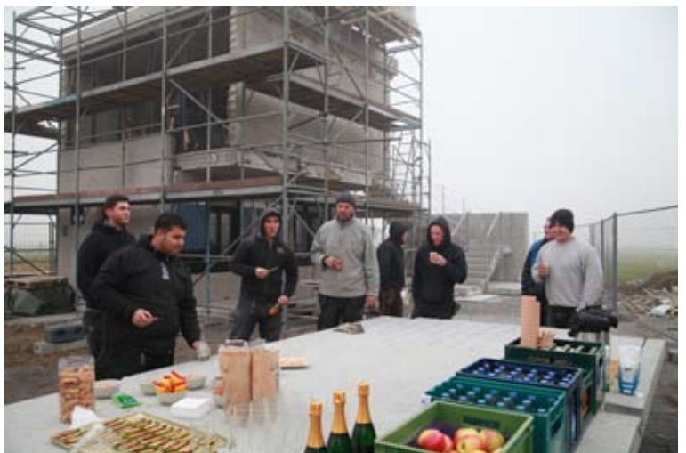
Lehrbaustelle und Richtfest am zweiten Standort auf der Tempelhofer Freiheit
