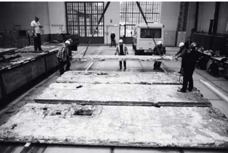
Anlieferung von Platten aus Frankfurt/Oder
